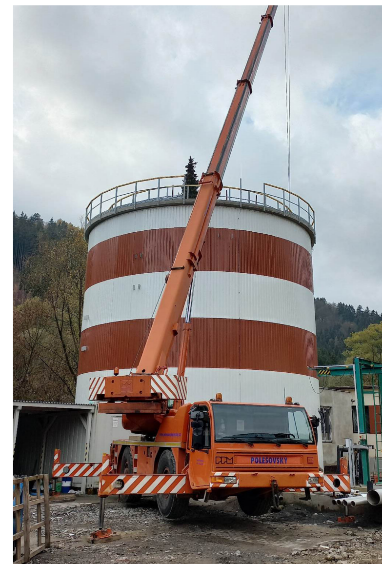
Železný Brod, ČOV – Rekonstrukce
