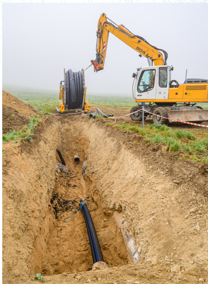
Roudnice nad Labem – Hostěraz – Rekonstrukce přivaděče
