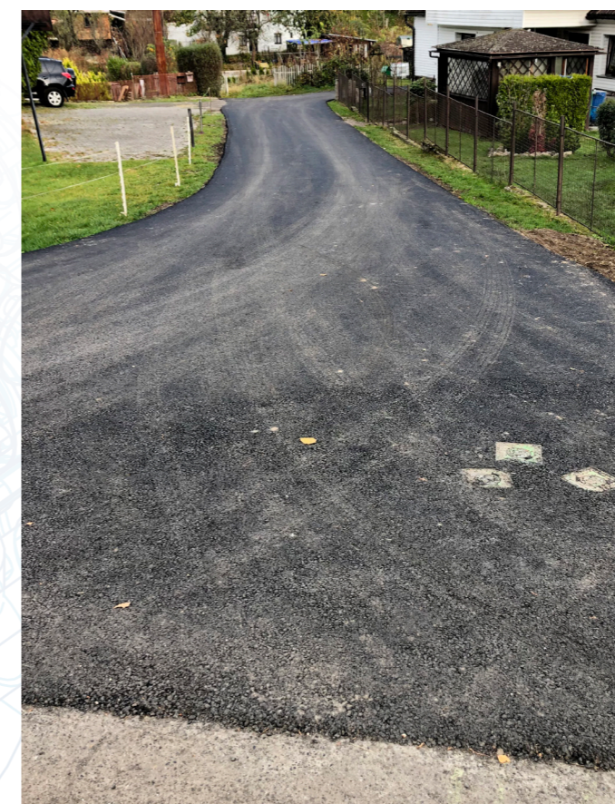
Lázně Libverda, lázeňská stezka – obnova vodovodu a povrchu
