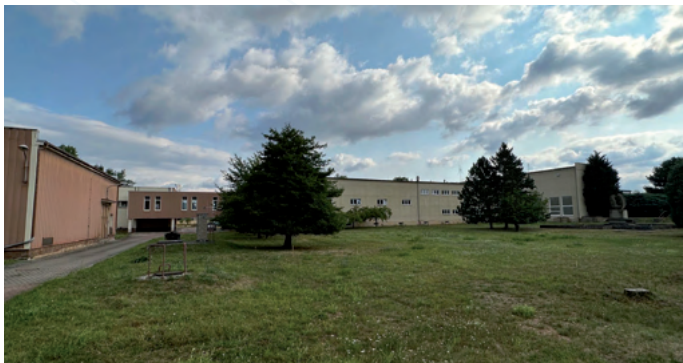
Úpravní vody Velké Žernoseky na počátku rekonstrukce
