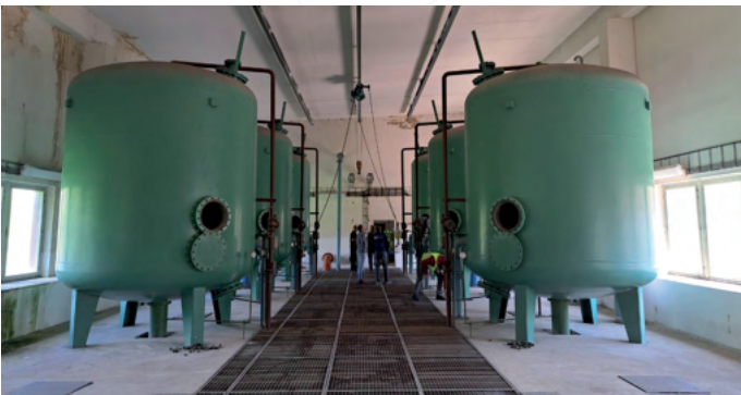
Úpravní vody Velké Žernoseky na počátku rekonstrukce
