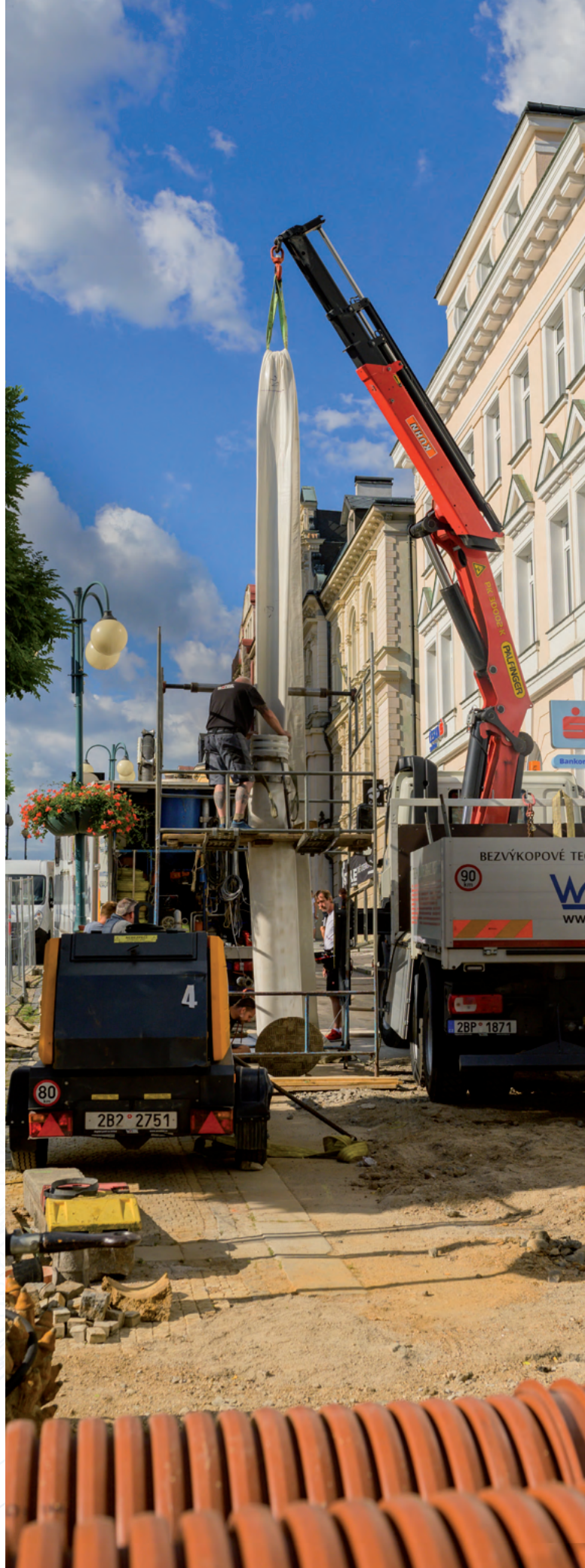
Kanalizace a vodovod | ul. Kamenná a Mírové náměstí, Jablonec n. N.
