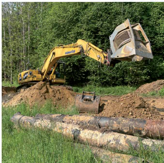
Výtlačný přivaděč | Libíč – Roveň
