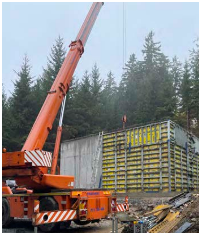
Zkapacitnění vodojemu Horní Proseč v Jablonci nad Nisou
